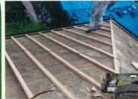
被災瓦を撤去
