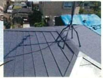
住宅の軽量化と耐震性能アップのために板金屋根に改修
